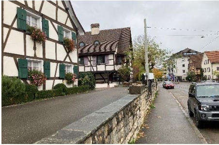
Abbildung 20: Eingedolter Dorfbach entlang der Baslerstrasse
