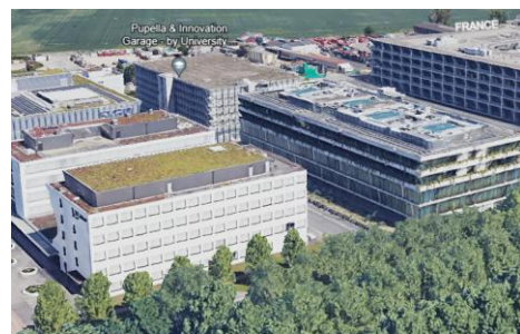
Referenz heute mögliche Ausnutzungsziffer, realisiert im Gebiet Bachgraben mit G20, ca. AZ 2.7
